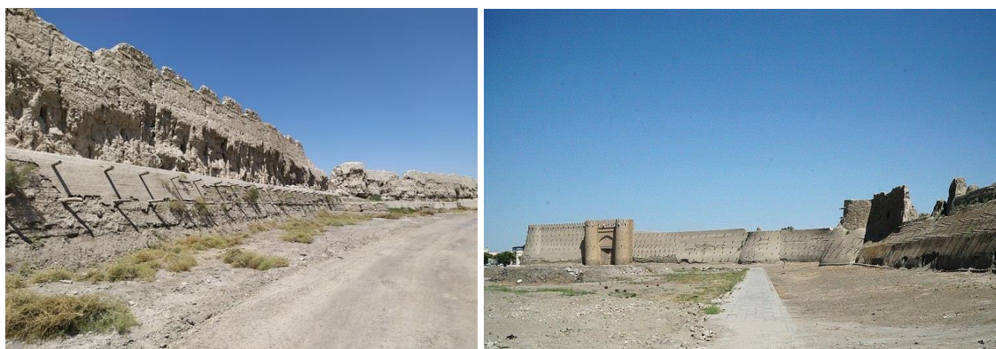
Рис. 2 – Сохранившаяся часть городской стены с проломами
