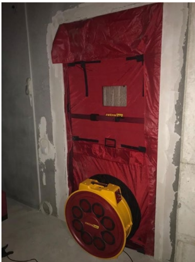
Рис. 2 – Аэродверь «Retrotec 5000», установленная в дверном проеме здания
