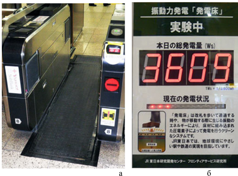
Рис. 4 – а) турникет с пьезоэлементом, б) дисплей турникета, отображающий количество генерируемой энергии и принцип работы
