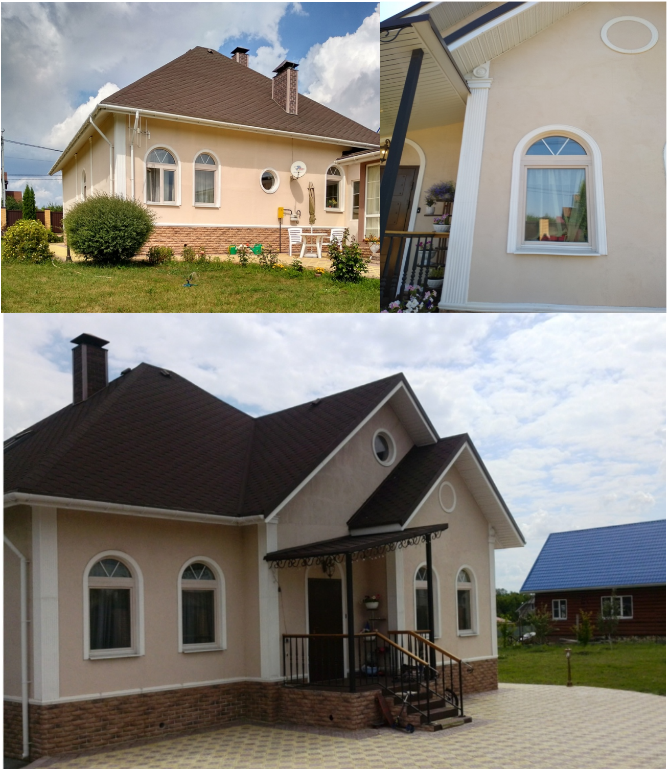
Рис. 1 - Фасады и детали дома, построенного на основе строительной системы монолитных композиционных гипсобетонов
