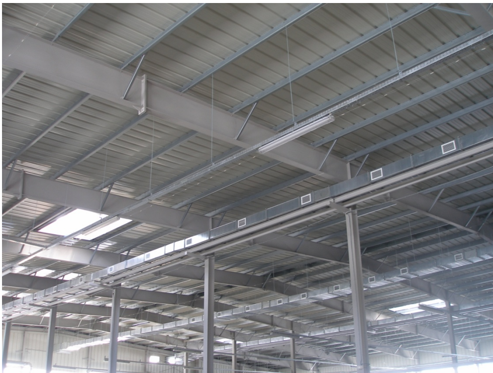
Рис. 2 – Общий вид производственно-складского корпуса
