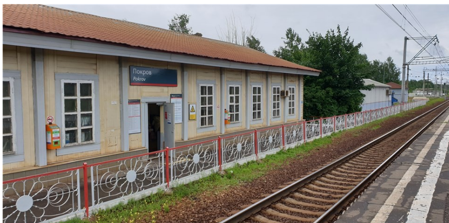
Рисунок 4 - Железнодорожная станция «Покров» DOI: https://doi.org/10.18454/mca.2023.37.2.4
