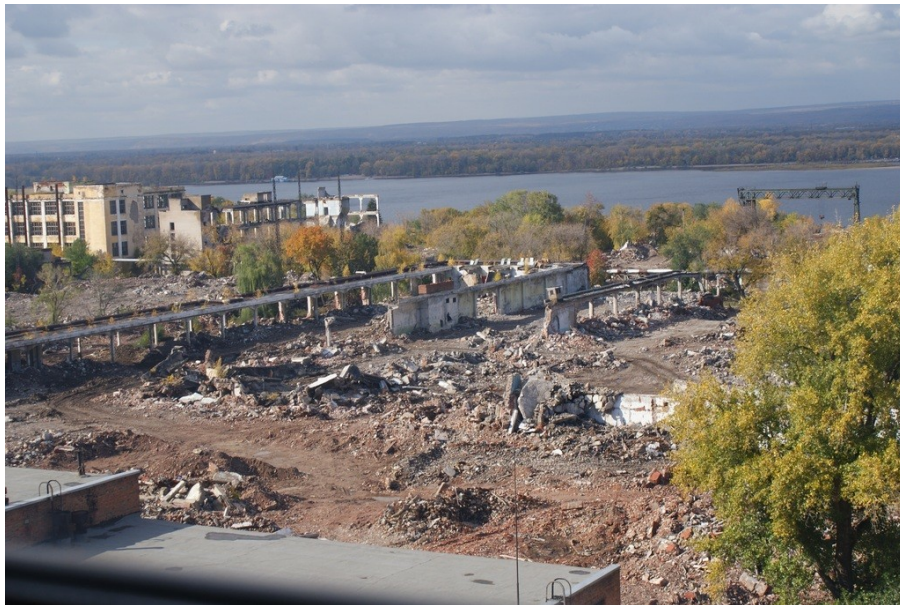
Рисунок 4 - Территория бывшего завода ЗИМ в г. Самаре. Современное состояние DOI: https://doi.org/10.60797/mca.2026.72.7.4
