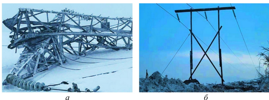
Рисунок 2 - Авария с падением стальных опор на оттяжках на 4-х ВЛ 154 кВ в 7 км от Мурманска в сторону Североморска в период 23.01-04.02.2026:
