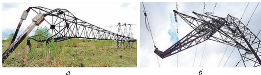
Рисунок 4 - Две схемы падения двухцепных промежуточных опор в групповой аварии на ВЛ 110 кВ в Кемеровской обл. от ветра:
