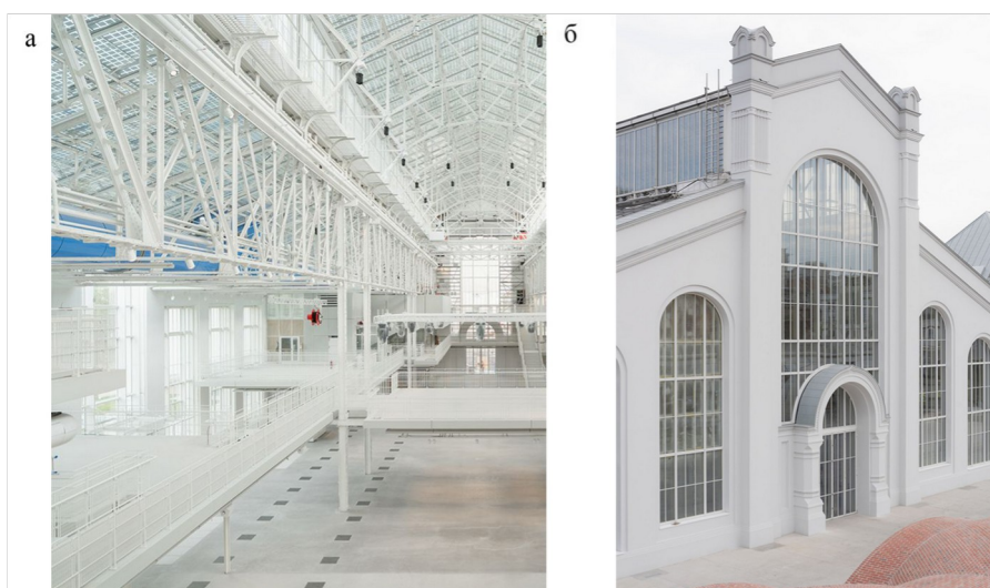
Рисунок 2 - Здание «ГЭС-2»: а - оригинальные стальные фермы, отреставрированные в процессе реконструкции; б - отреставрированный фасад здания DOI: https://doi.org/10.60797/mca.2025.59.2.2
