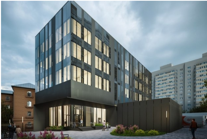
Рисунок 4 - Проектное решение кампуса Московского государственного технического университета им. Н.Э. Баумана, г. Москва
