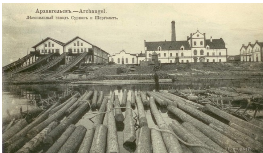
Рисунок 2 - Лесопильный завод Сурков и Шергольд DOI: https://doi.org/10.60797/mca.2024.48.1.2
