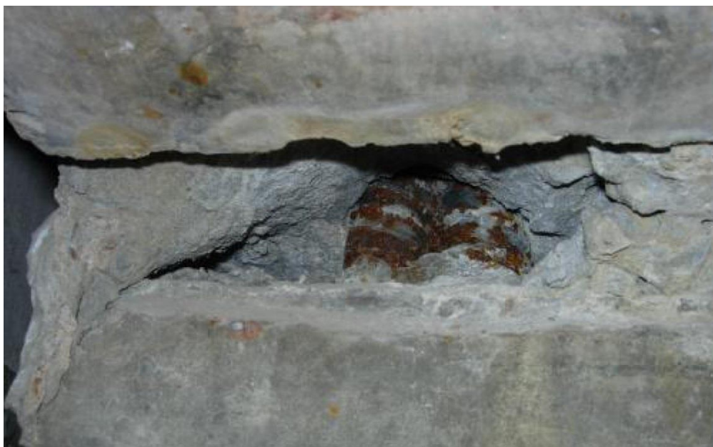
Рис. 2 – Непробетонированные участки, обнаруженные при обследовании
