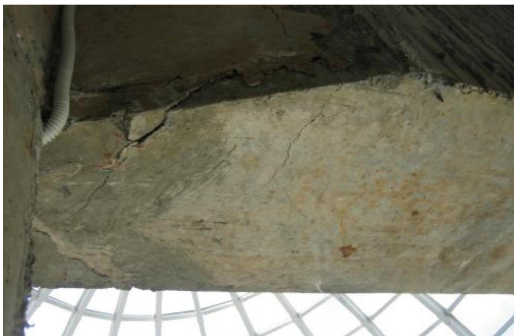
Рис. 1 – Раскрытие наклонных трещин в приопорной зоне
