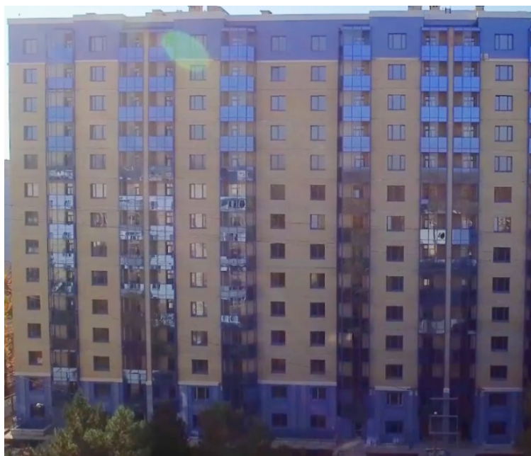
Рис. 2 – Фасад строящегося дома
