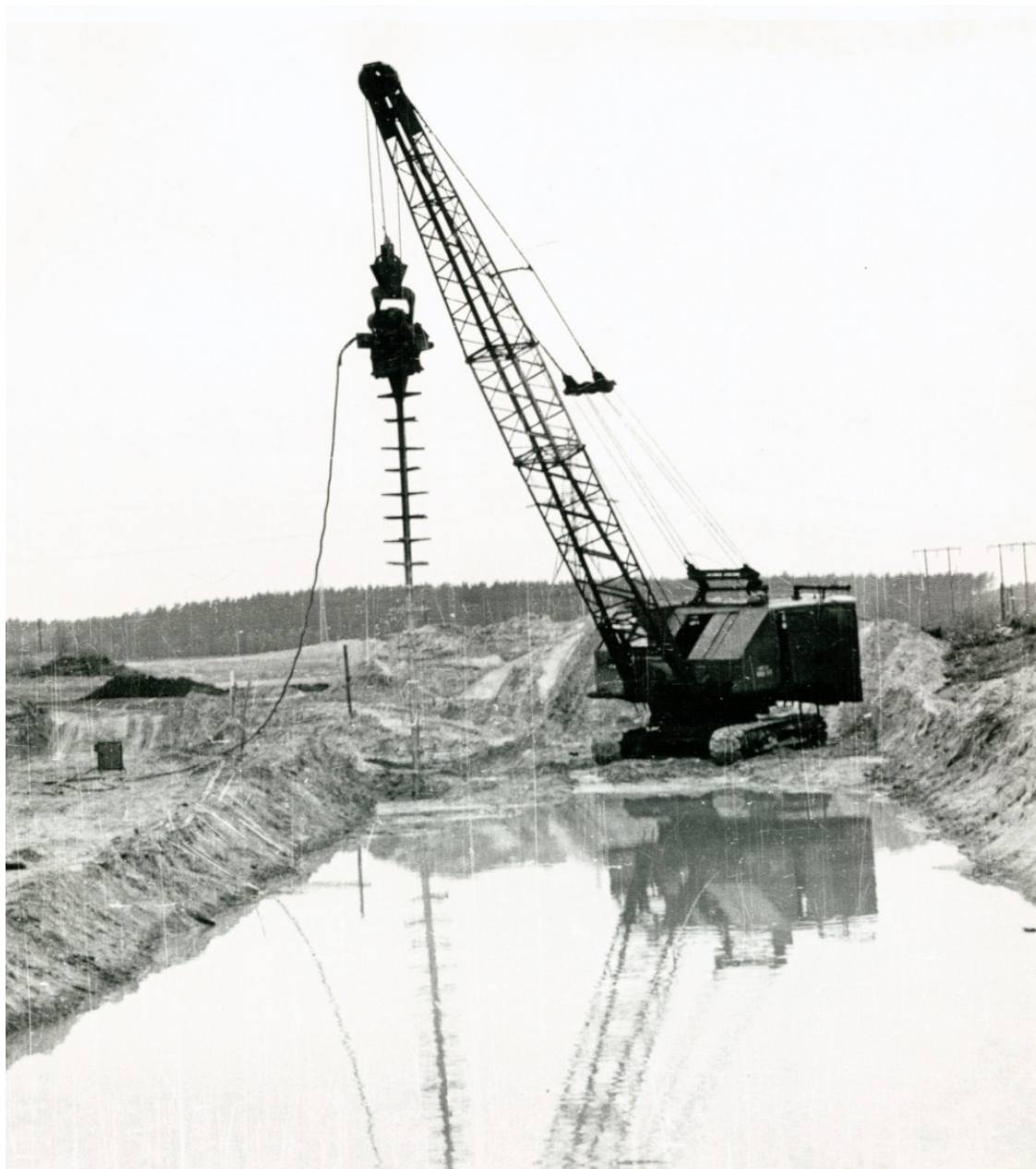
Рис.10 – Грунтоуплотняющая вибрационная установка ВУУП-6 «Елочка» ВНИИГС
