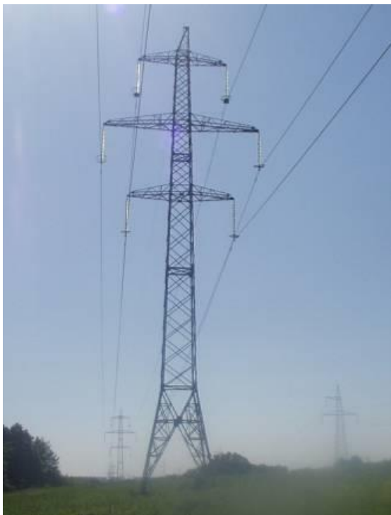
Рис. 3 – Общий вид промежуточной опоры ВЛ 220 кВ «Александрия - Северная» (Кировоградская обл.)
