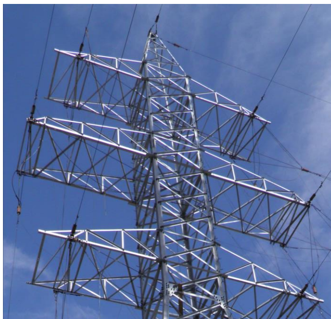
Рис. 5 – Узлы крепления проводов с расстановкой измерительных приборов
